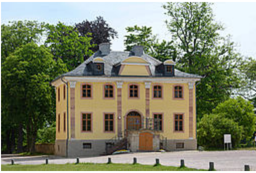
Bachhaus | Foto: Maik Schuck
